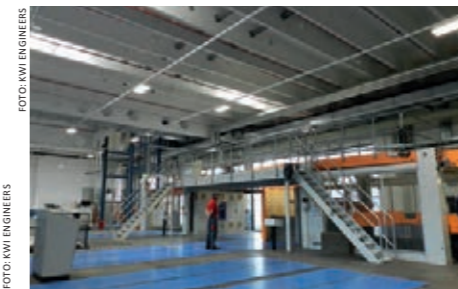
Durch den Neubau konnten die innerbetrieblichen Abläufe bei der Wellpappe-Produktion entflochten werden
