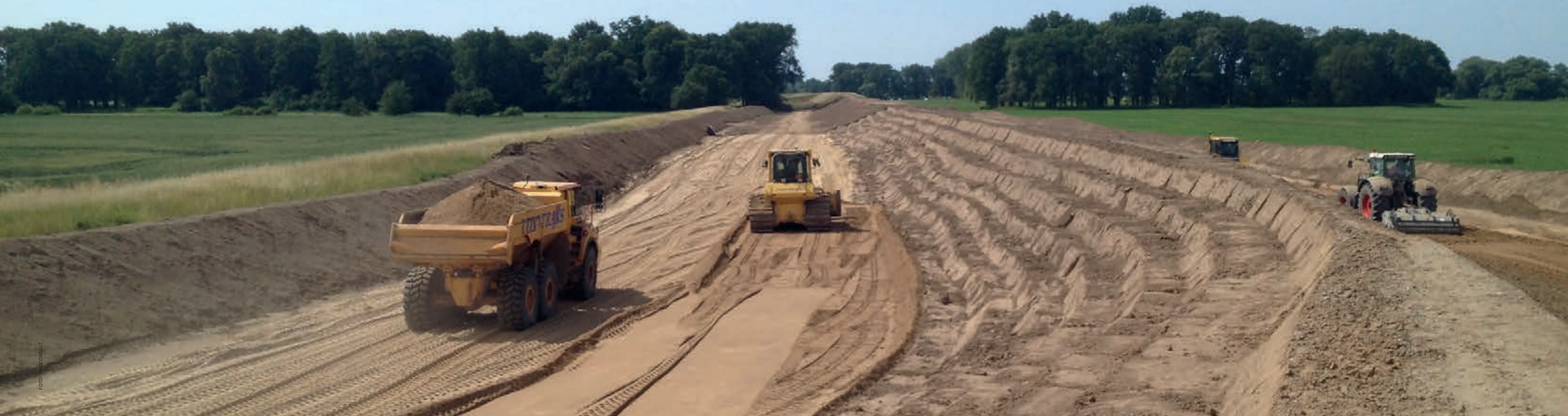
Der Elbdeich wird abschnittsweise um einen halben Meter erhöht und ertüchtigt
