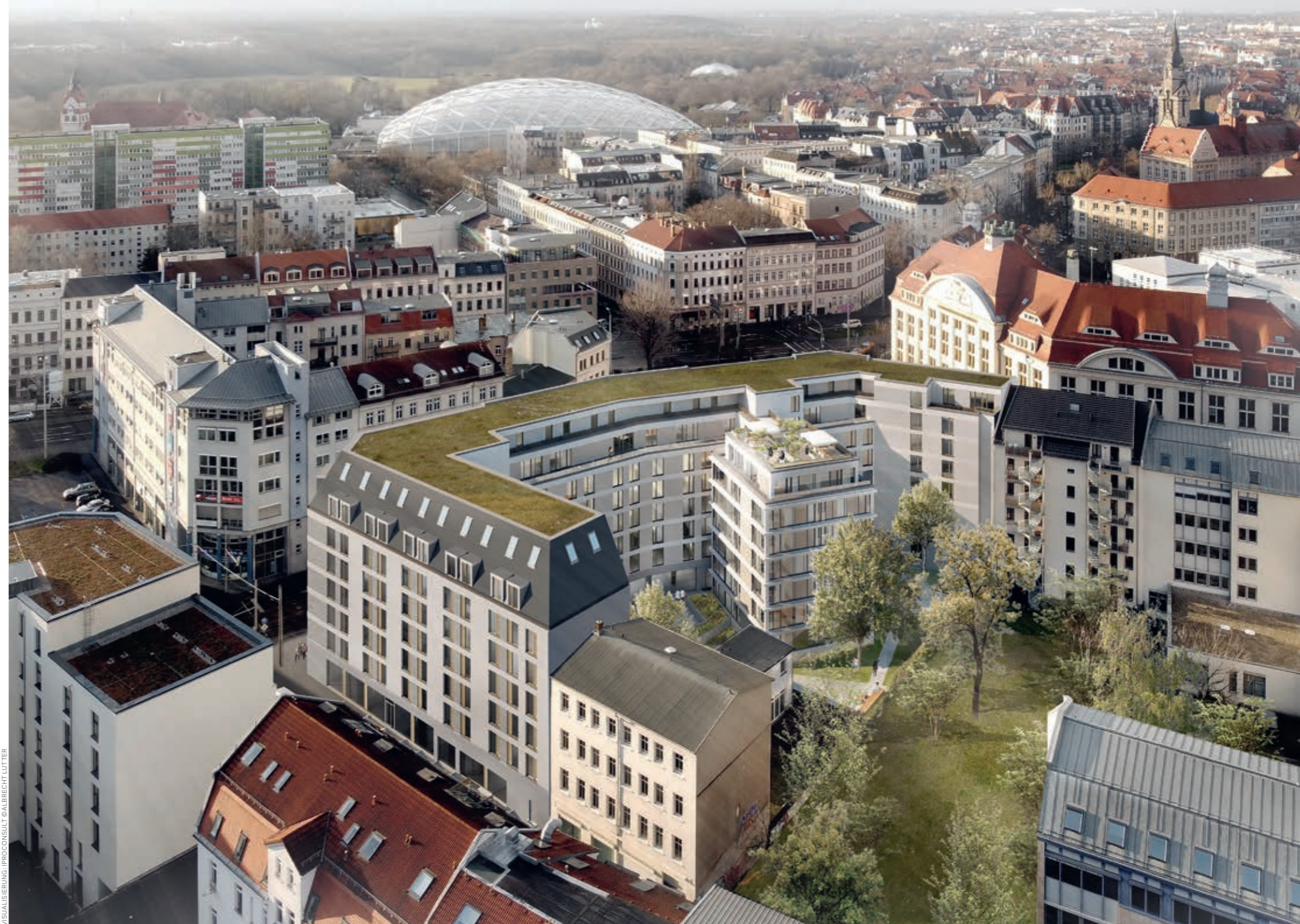
↑ Das neue, fast u-förmige, Studentenwohnheim schließt das Leipziger Quartier in Blockrandbebauung
