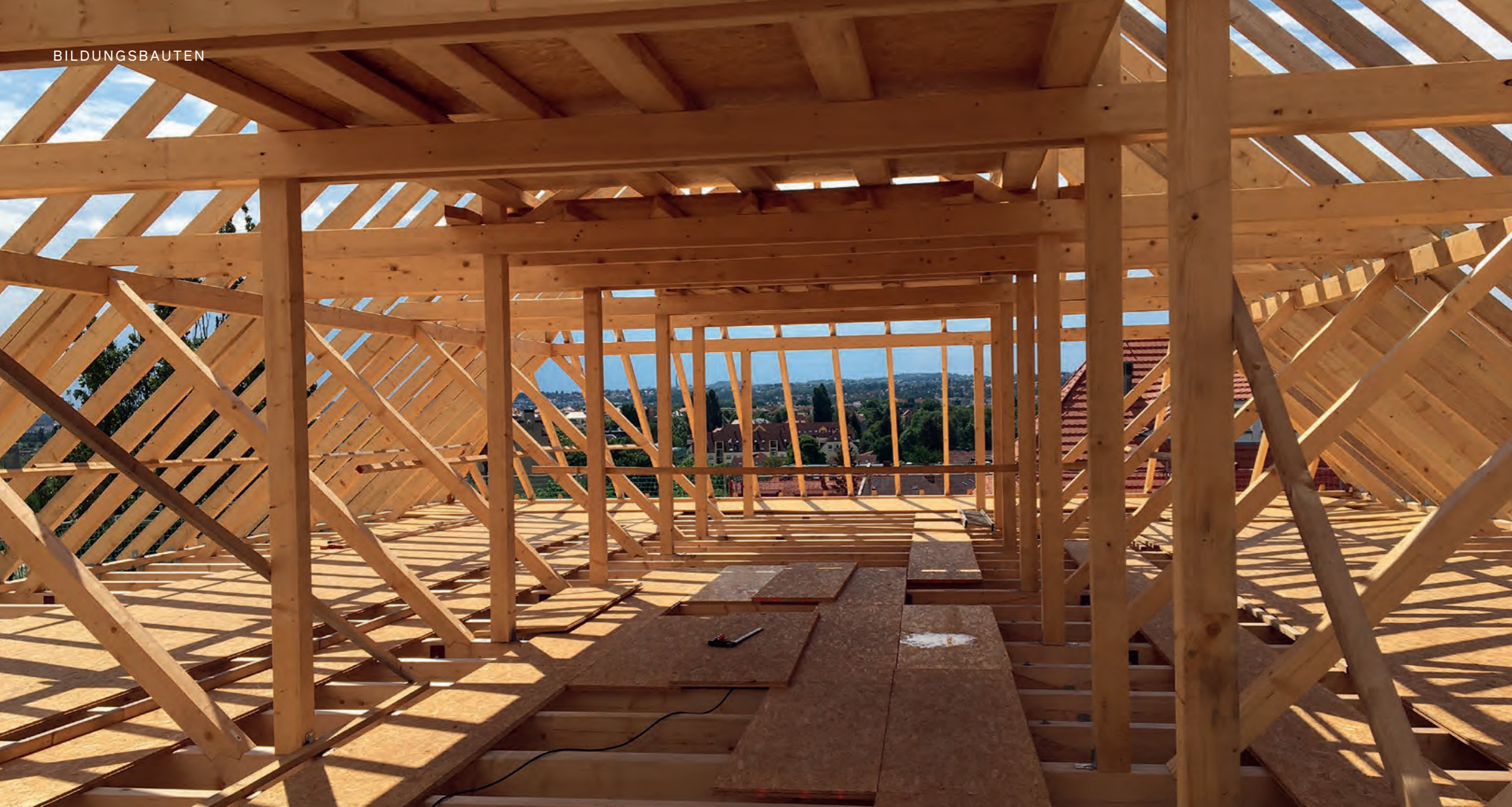
↑ Für die Dachkonstruktion allein wurden 125 Kubikmeter Holz benötigt
