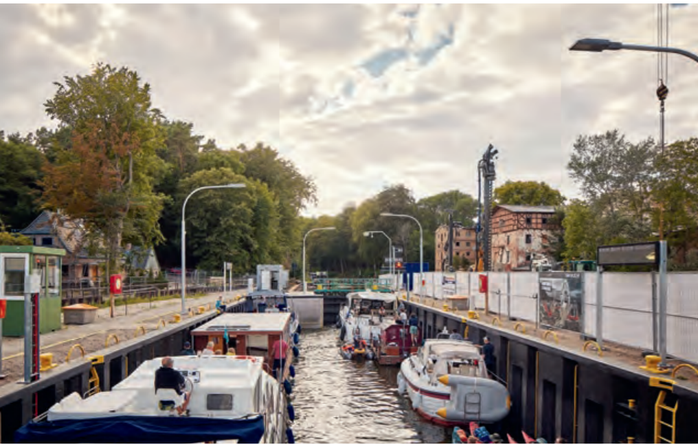
Zwischen dem Röblinsee und dem Menowsee fließt die Havel an der Steinhavelmühle vorbei. Die dortige Staustufe mit Schleuse und Wehr ist jetzt wieder voll funktionstüchtig
