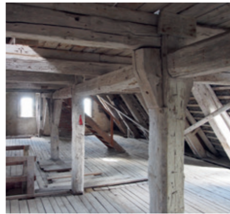
↑ Blick in den historischen Dachstuhl
