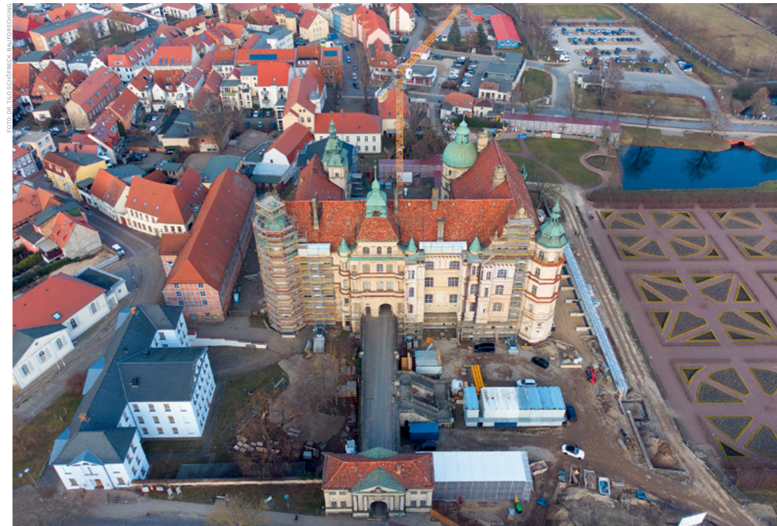
↑ Nach der Sanierung soll das Schloss wieder ein Museum, unter anderem für norddeutsche Kunst des Mittelalters werden
