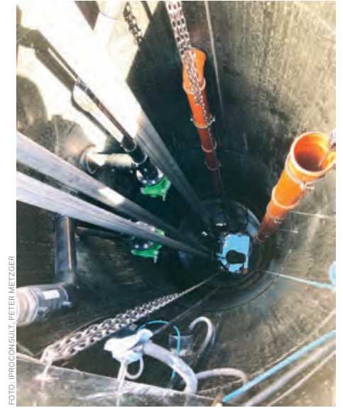
↑ Blick in das neu errichtete Schmutzwasser-Pumpwerk
