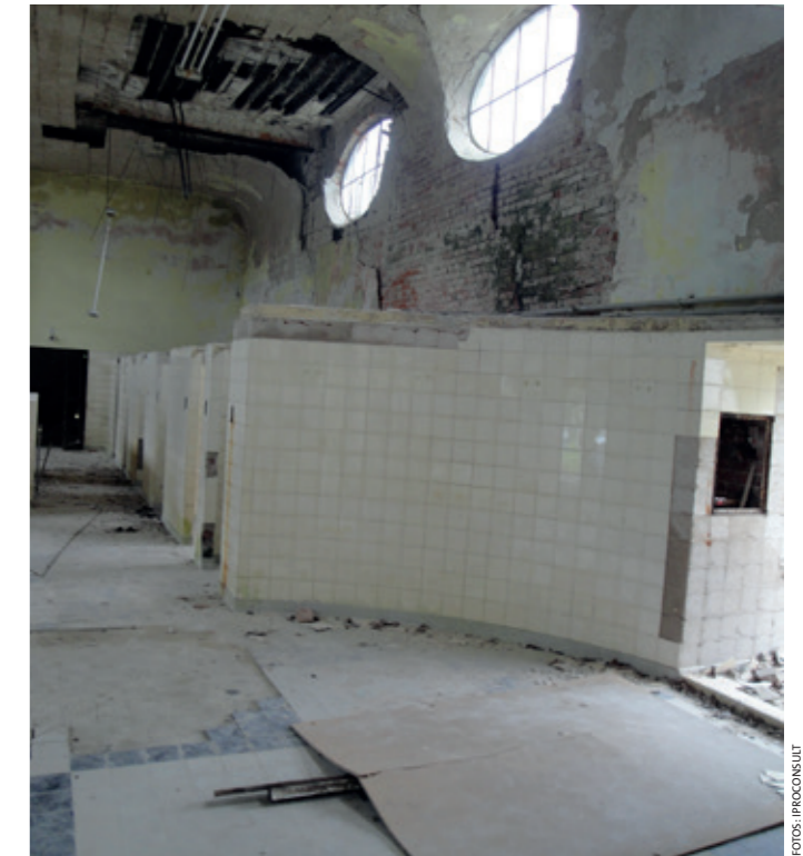
Zustand des Damenbades vor der Rekonstruktion
