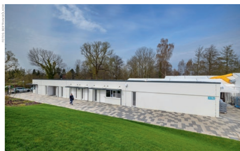
↑ Eingangsgebäude für Ticketschalter, Sanitär- und Lagerflächen am Zugang zum Festspielareal
