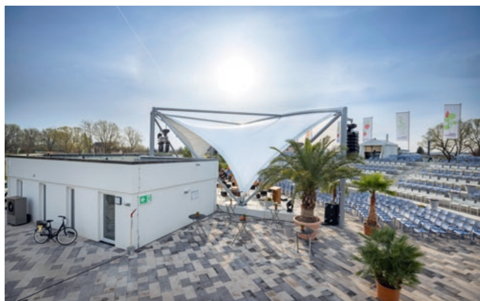
↑ Das Umkleidegebäude wurde an die Freilichtbühne und ihr Bühnendach angegliedert
