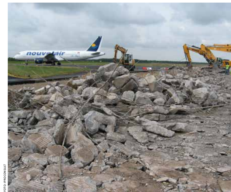
Die Betonabbrucharbeiten an der Querwindbahn
