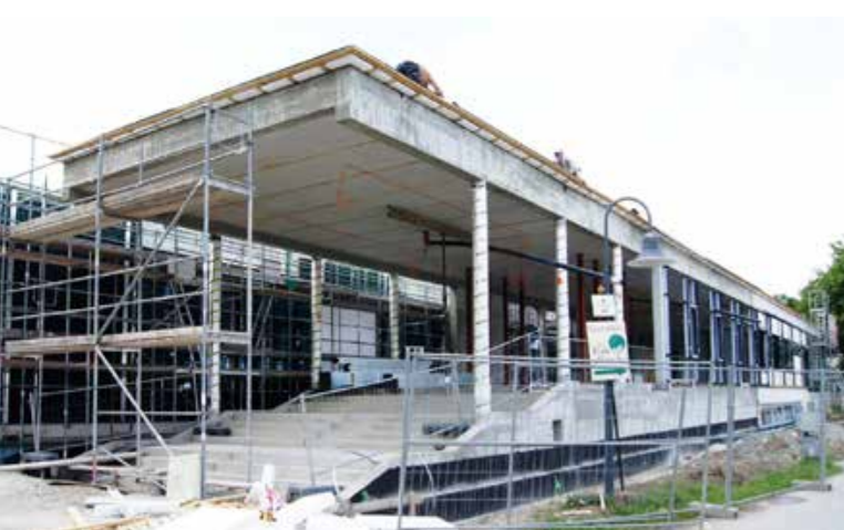
Das neue Eingangsbauwerk des Therapiezentrums nimmt Gestalt an.
