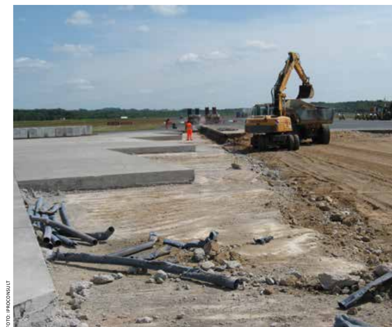
■ Untergrundvorbereitung für späteren Asphaltteinbau
