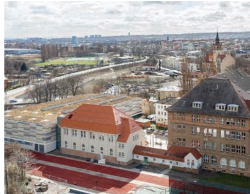
Die ehemalige Turnhalle als Teilprojekt der Schulsanierung
