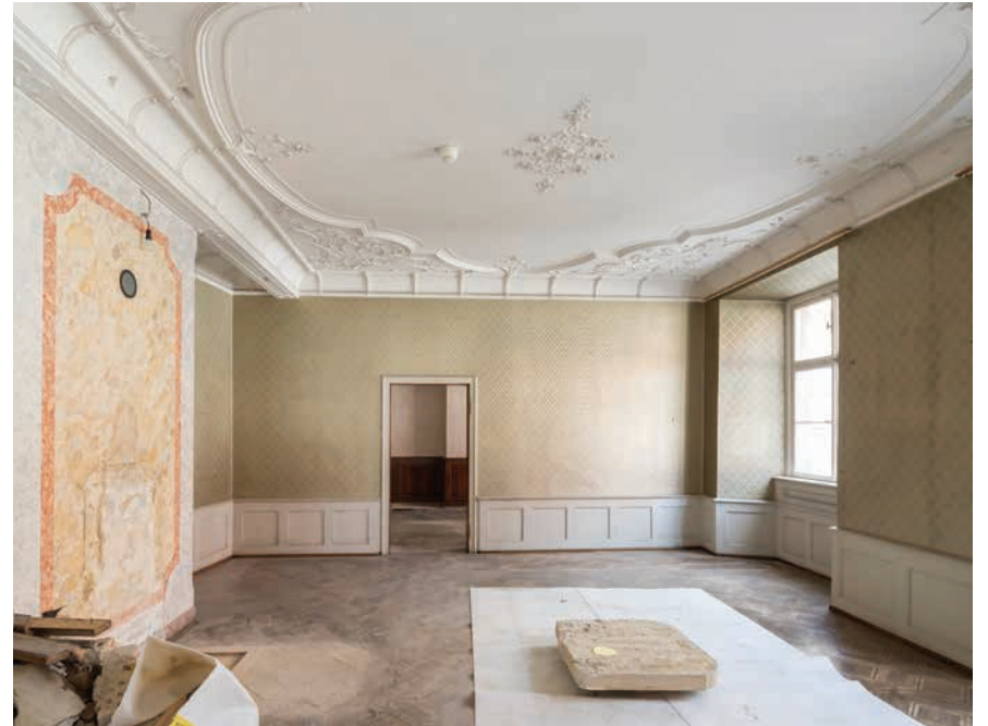
Restaurierung der Innenbereiche
